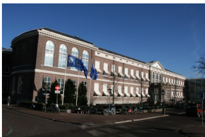
Kamerlingh Onnes Gebouw Universiteit Leiden: Steenschuur 25, 2311 ES Leiden
